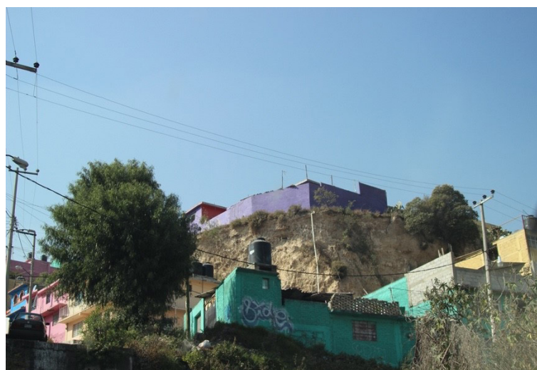
Figura 9. Viviendas en riesgo.
