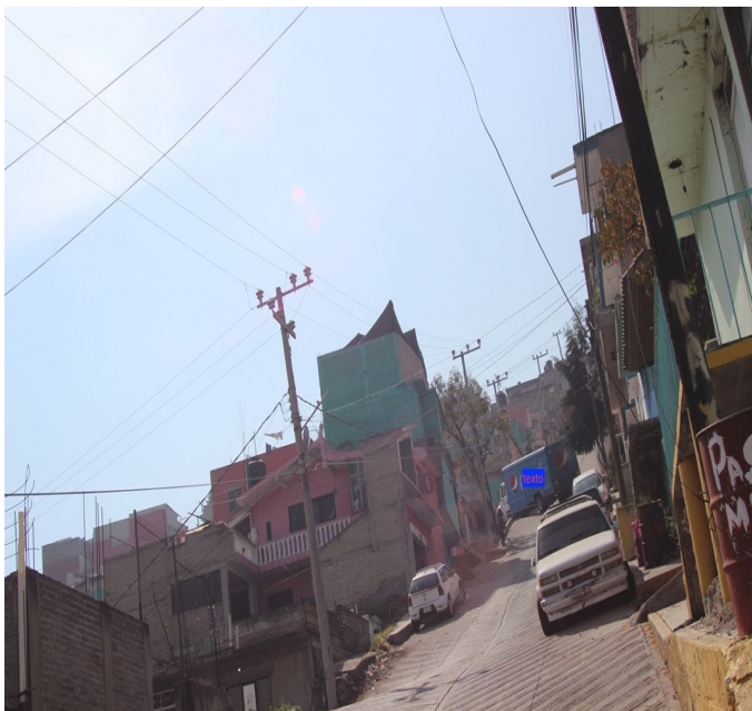
Figura 10. Riesgo de accidentes por pendientes pronunciadas.
