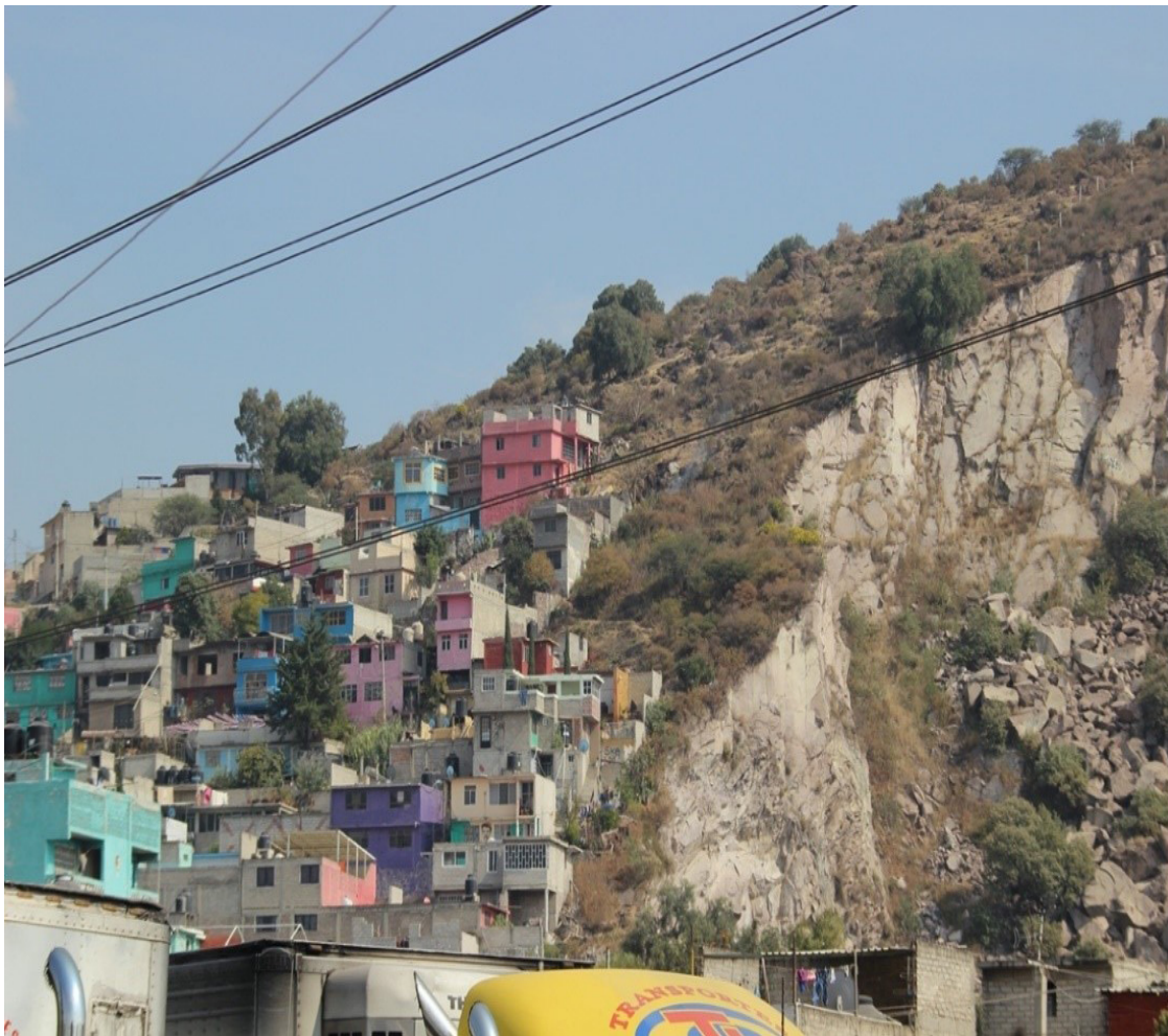
Figura 12. Riesgo por deslizamiento de laderas.
